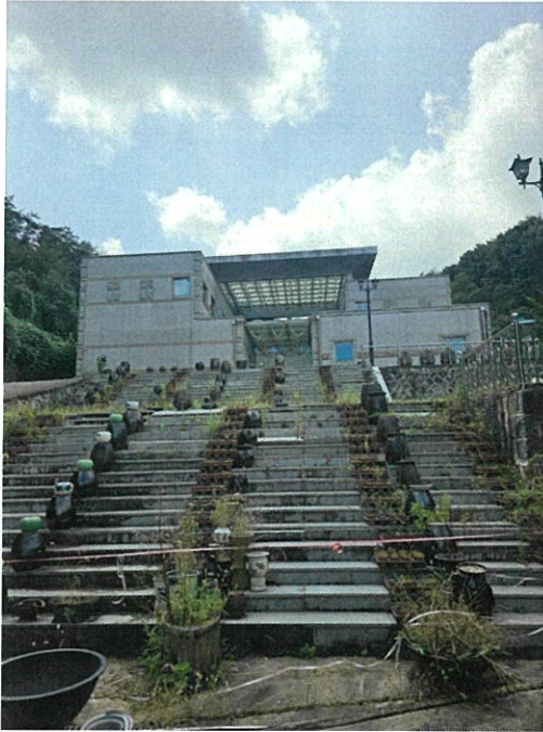
1-1건물 1,2층 전경
