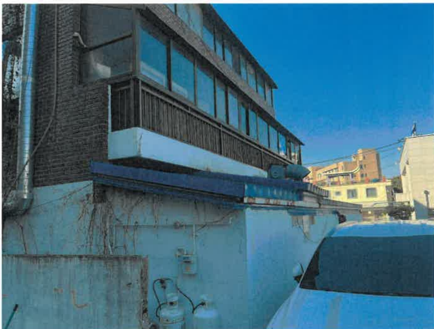
건물 기호8) 1층 증축부분
