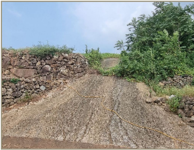
기호(2) 남서측 도로 전경
