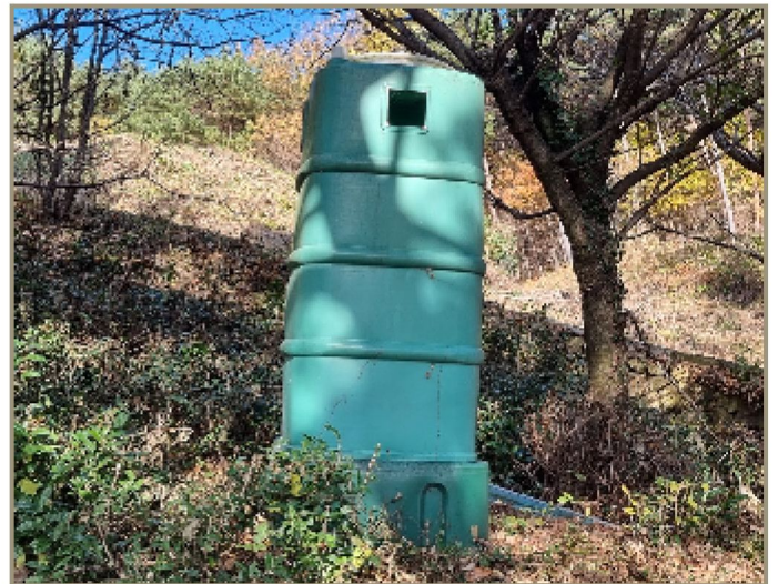
일련번호(17) 지상 간이화장실(평가 제외) 전경
