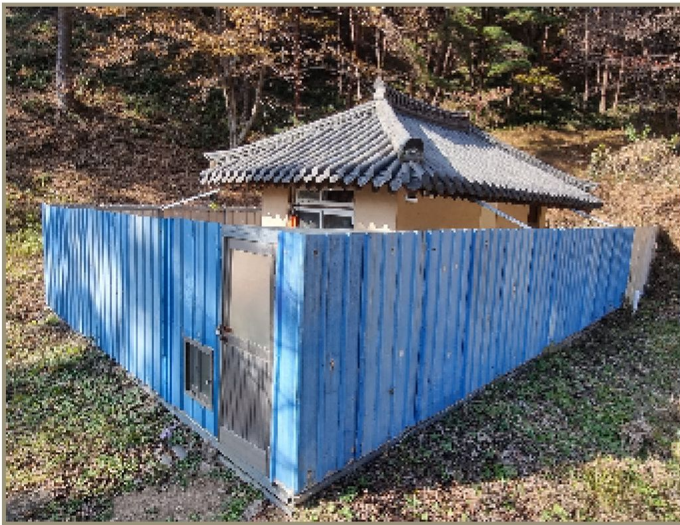
일련번호(22) 및 철제펜스 전경
