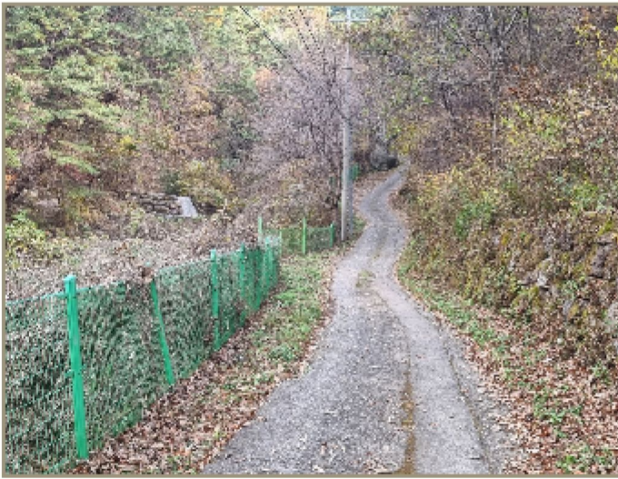
일련번호(32,33) 및 철제올타리 전경
