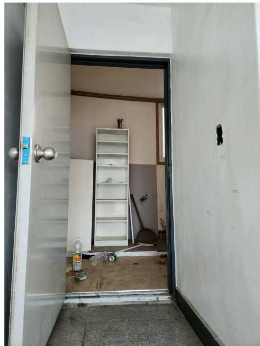
4층 주택 현재 공사
