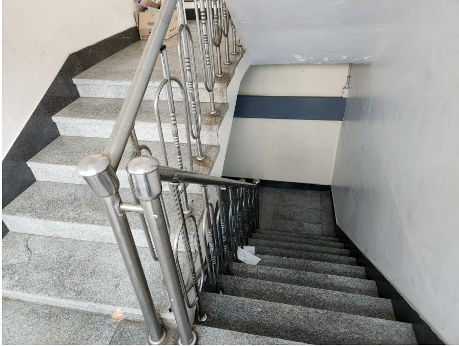
본건 건물 출입계단의 전경
