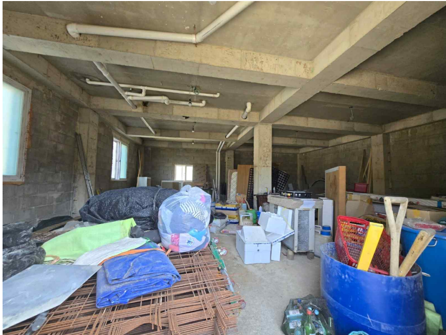
기호(2) 1층 창고 내부
