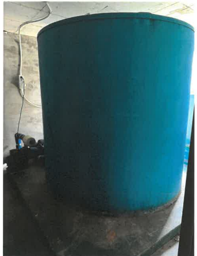
건물 기호(2) 물탱크 시설
