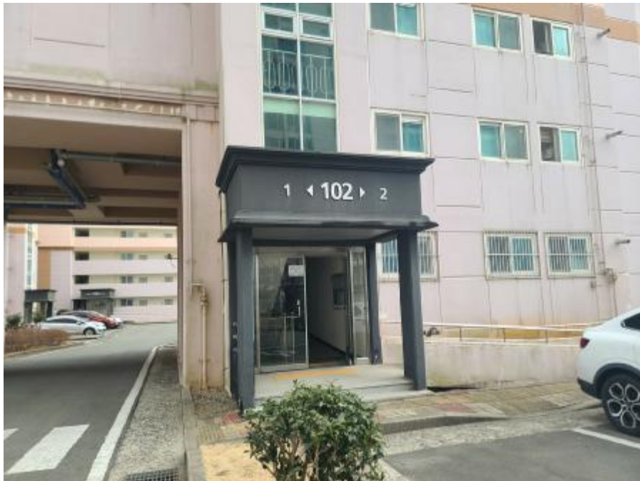
102동 1층 출입구(1,2호라인)
