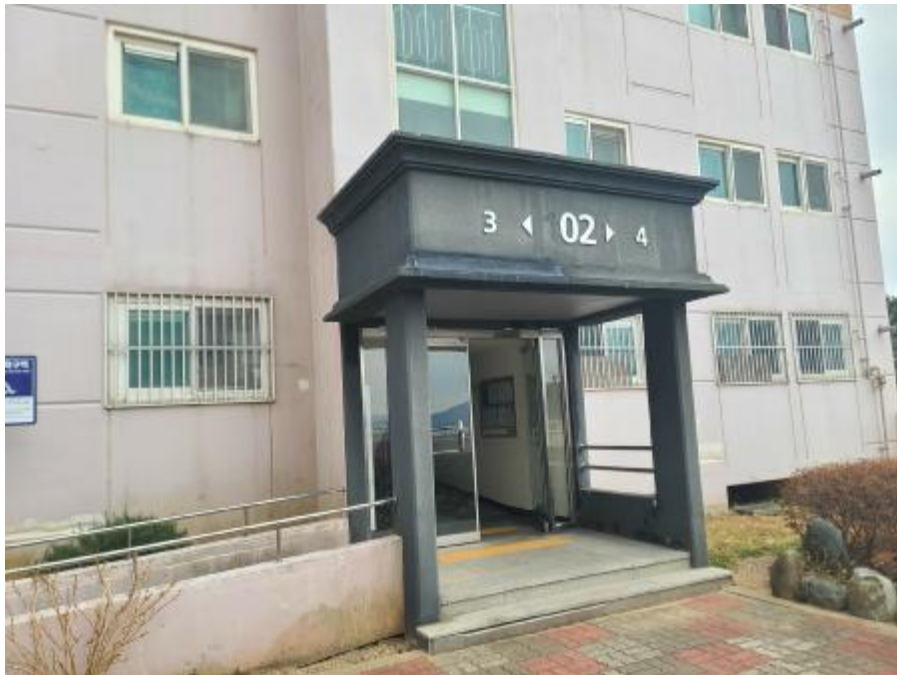
102동 1층 출입구(3,4호라인)
