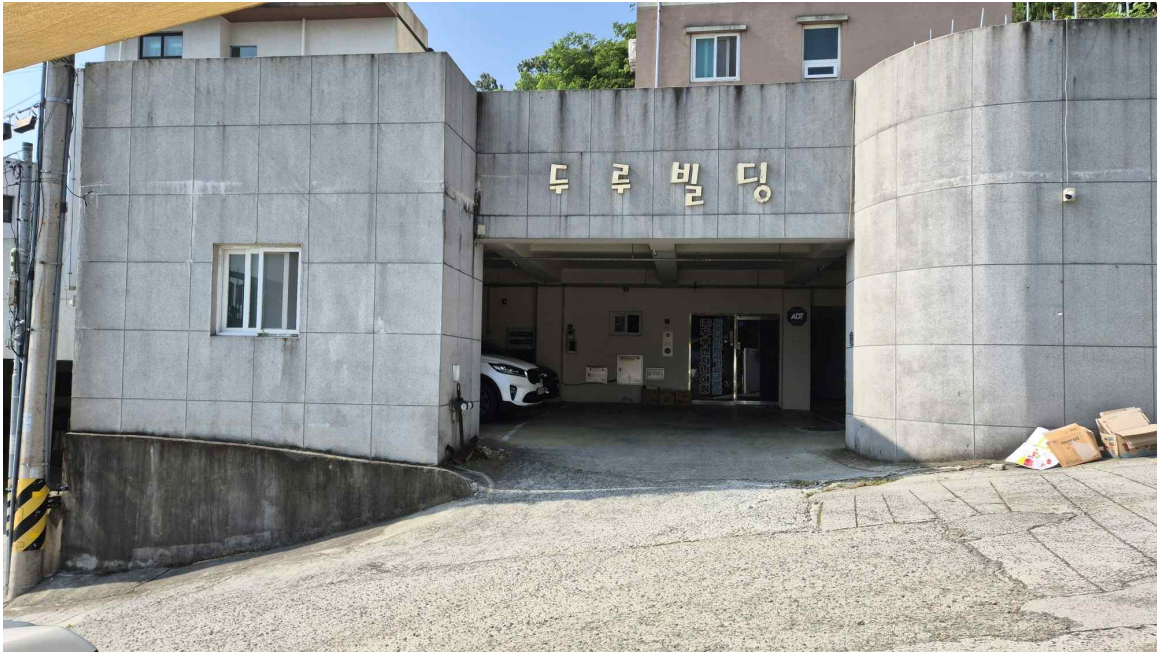
[ 본건 전경: 지하1층 ]
