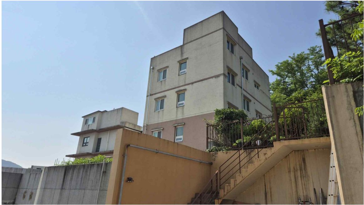
[ 본건 전경: 1~4층 ]
