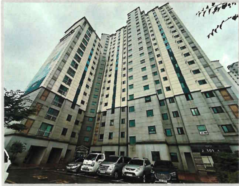
【1. 본건 건물 전경】
