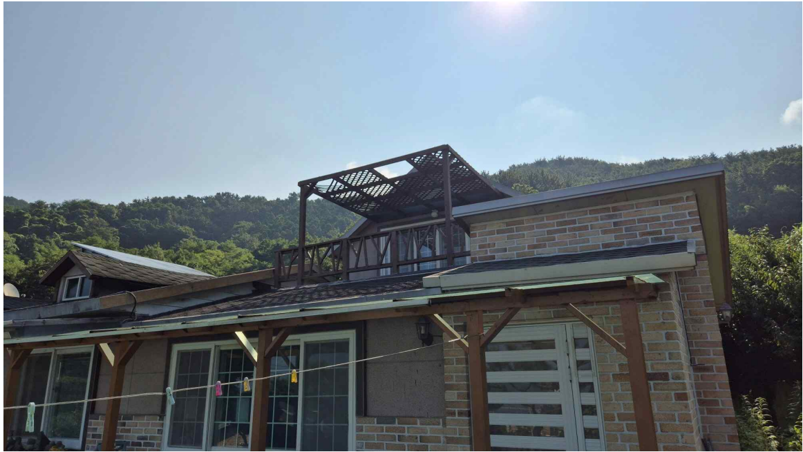
[ 본건 전경: 기호 ② 2층 ]
