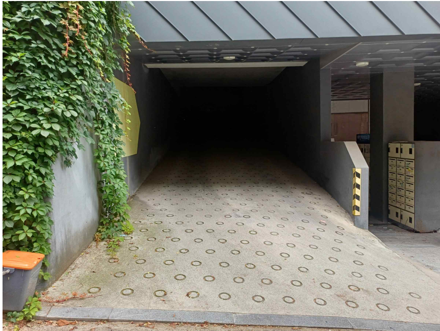
지하2층 주차장 입구
