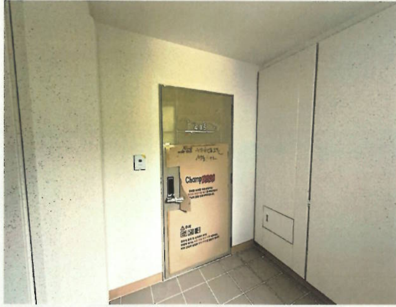
【15. 본건 기호(13) 현관문 전경】
