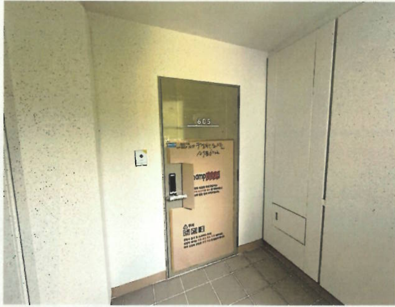
【13. 본건 기호(11) 현관문 전경】
