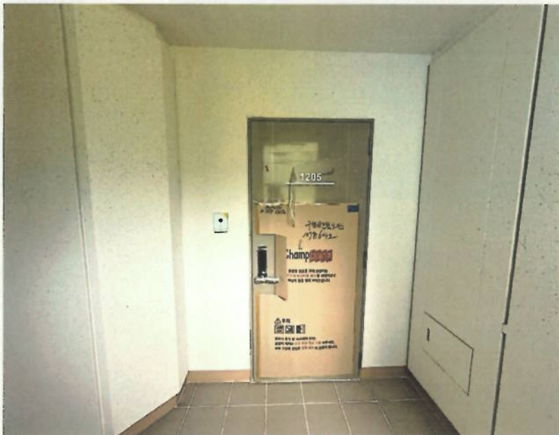
【8. 본건 기호(6) 현관문 전경】
