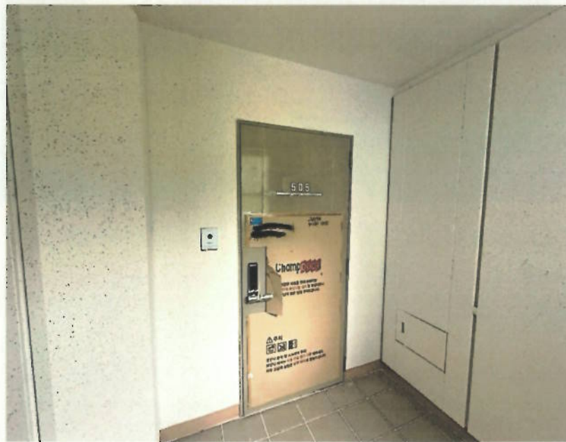
【14. 본건 기호(12) 현관문 전경】
