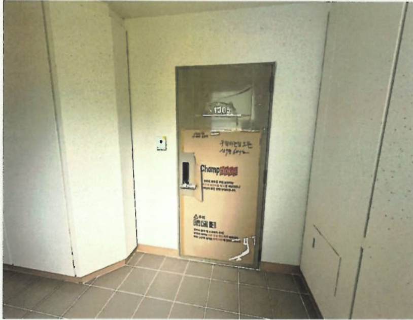
【7. 본건 기호(5) 현관문 전경】
