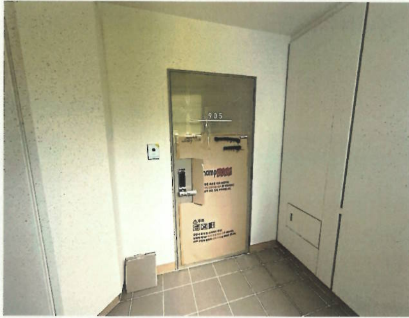
【11. 본건 기호(9) 현관문 전경】
