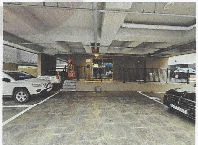
1층 현관 및 주차장
