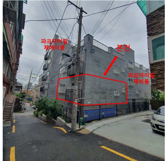
본건 전경 및 동측 인접도로 주위환경
