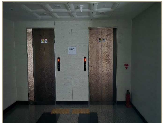
2층 승강기실 전경
