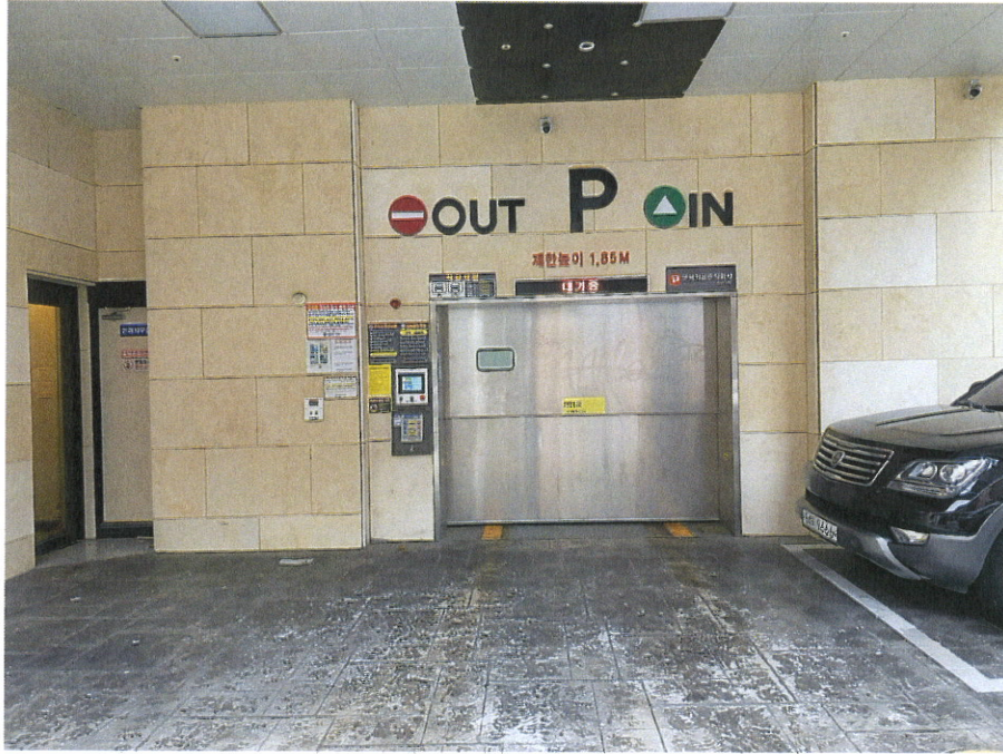
본건동 기계식주차장 출입구 전경
