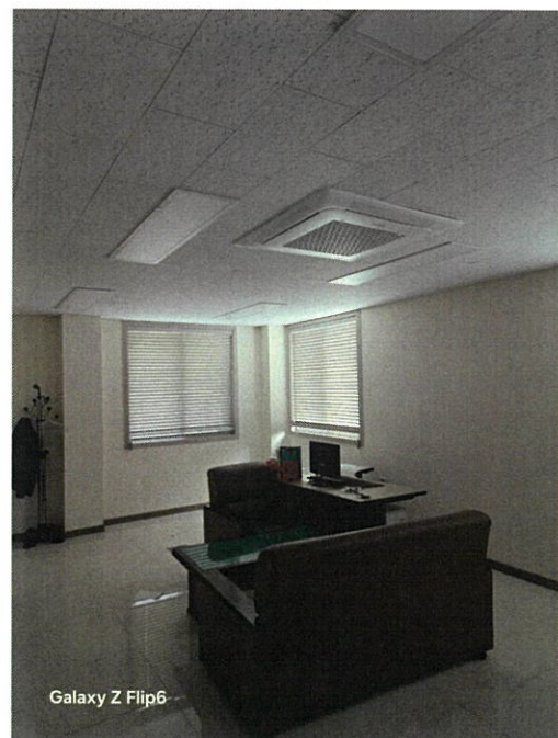
일련번호(4)건물의 2층 사무실
