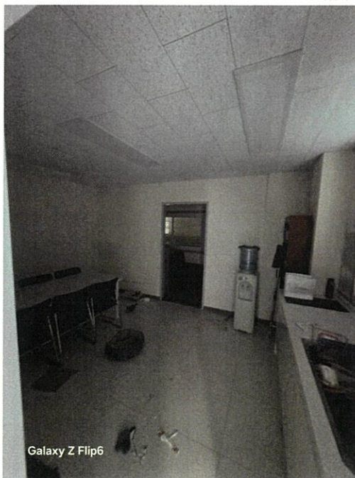
일련번호(4)건물의 1층 내부
