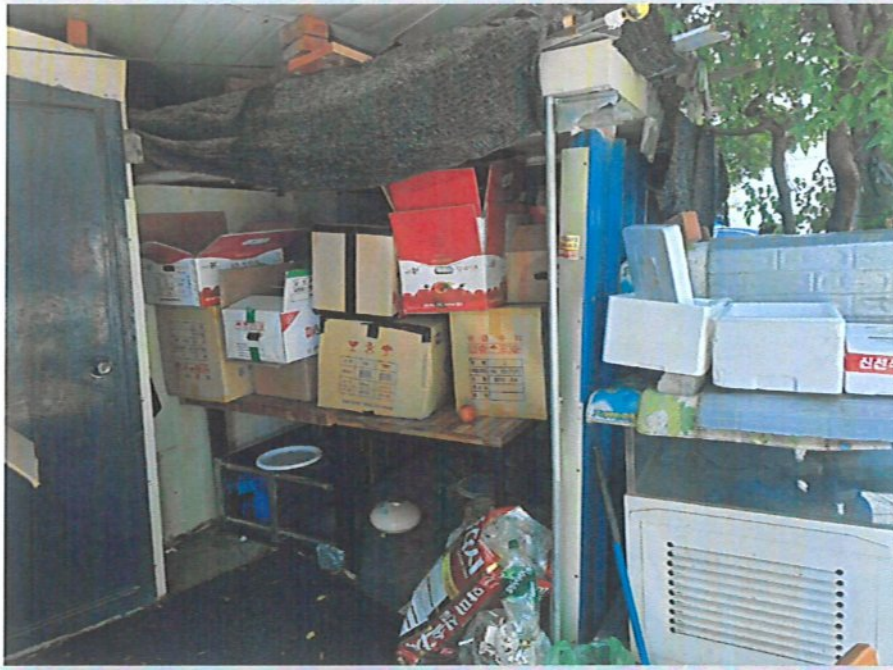
101호 부합부분(창고) 외부전경
