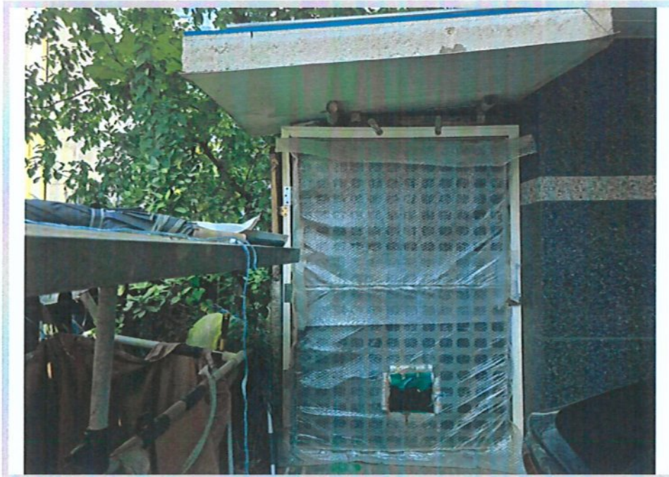
101호 부합부분(창고) 외부전경
