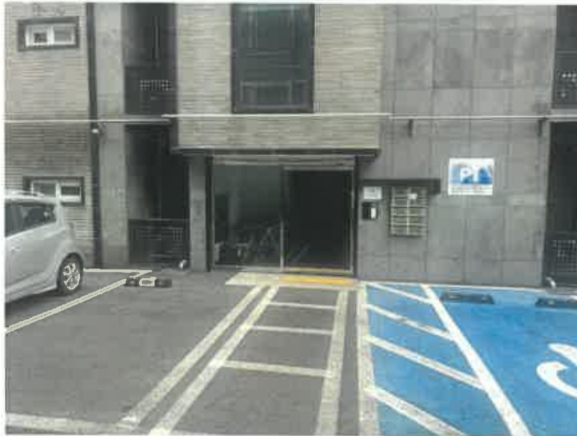
[ 대상물건 건물 공동출입구 전경 ]
