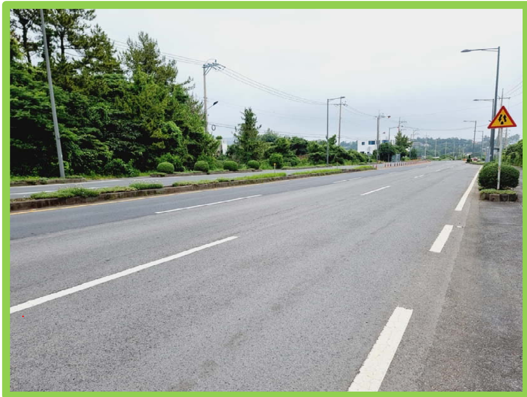
(기호(1)-(3) 접면도로 전경 )
