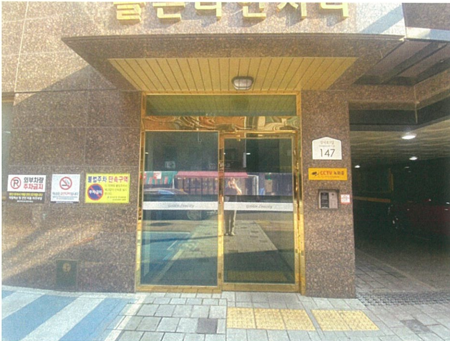
본건 소재 건물 공동출입구
