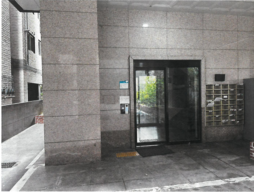
1층 출입구 전경
