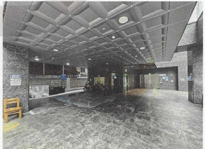
1층 현관 및 주차장
