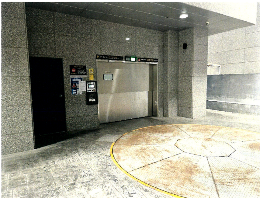
본건이 속한 건물 기계식 주차시설
