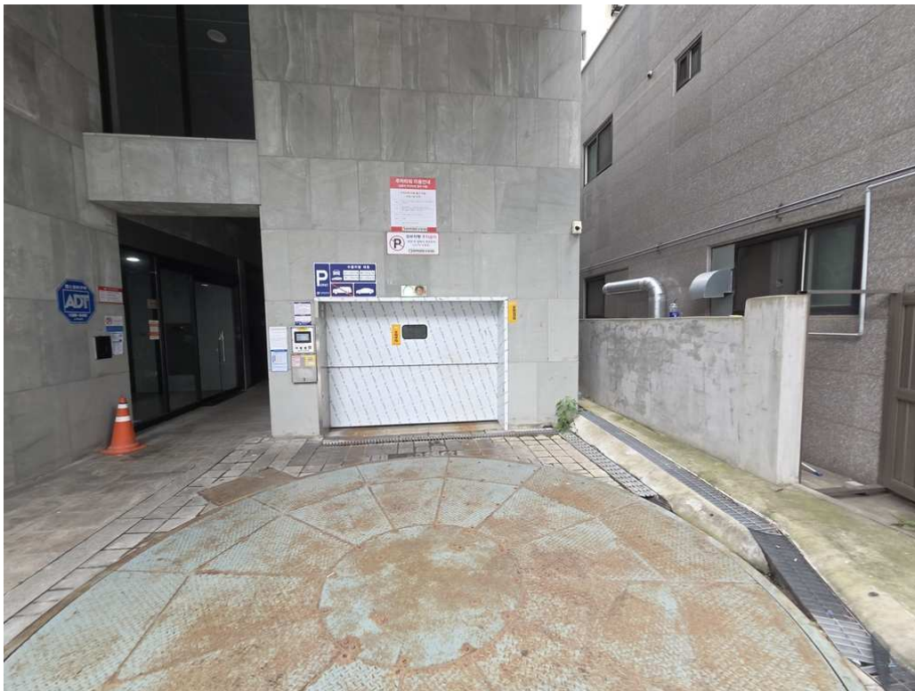
본건 기계식 주차장
