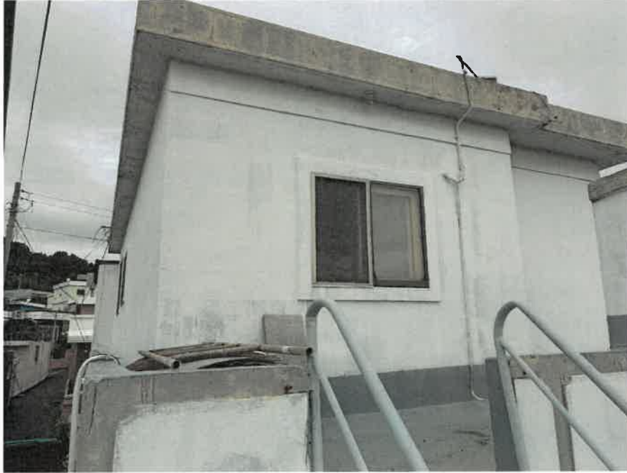
제시외 건물 ㄷ(주택)
