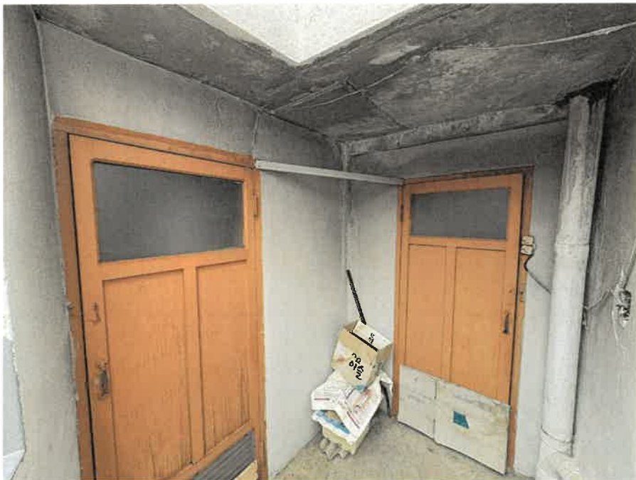
본건 기호2) 변소 및 창고 전경
