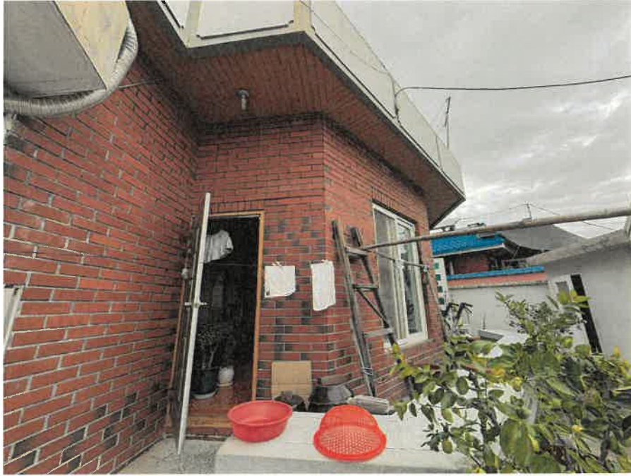
본건 기호2) 주택 전경
