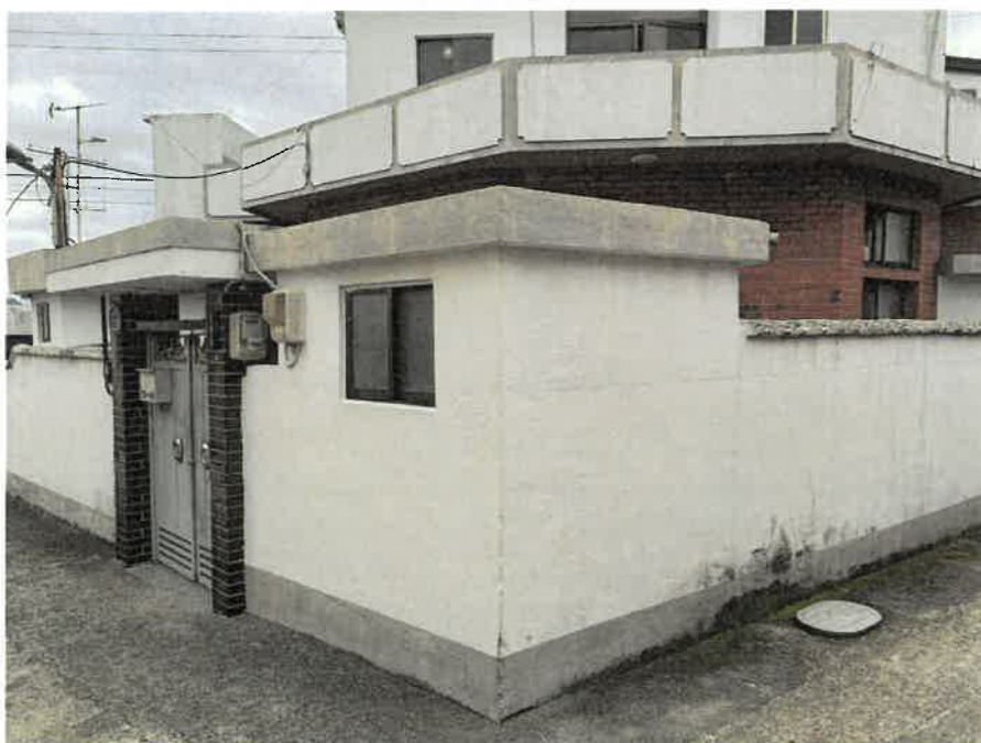
본건 기호2) 주택 전경
