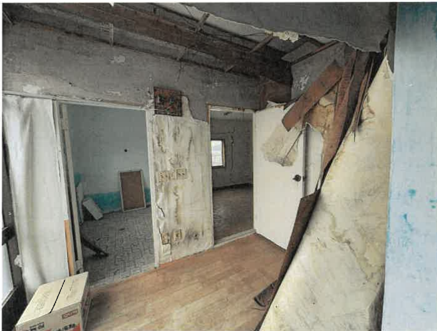
제시외 건물 ㄷ(주택 내부)
