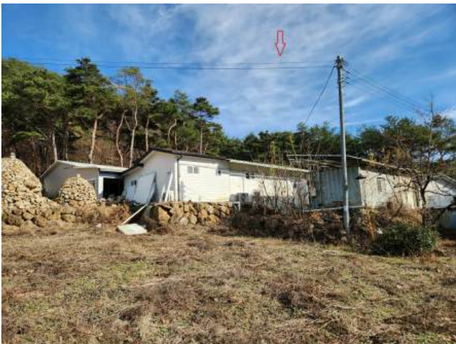
기호9 토지의 전경 및 서측부분의 전경 남서측 지적경계 부근에서 북동측을 향하여 촬영
