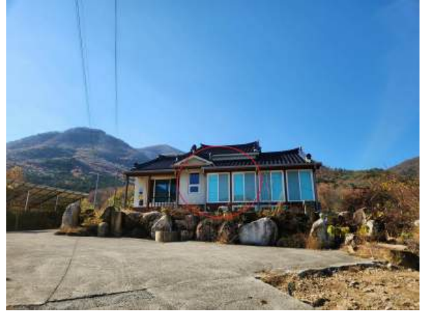
기호5 건물의 전경 남동측에서 북서측을 향하여 촬영
