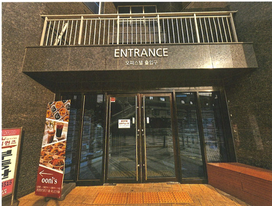
본건 소재 건물 공동출입구
