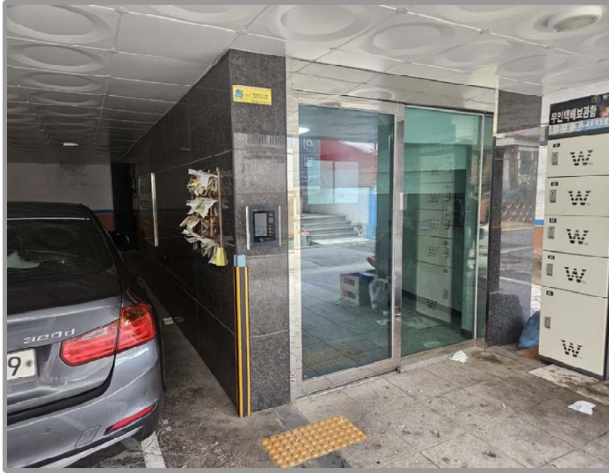
[03. 공동 현관 전경]
