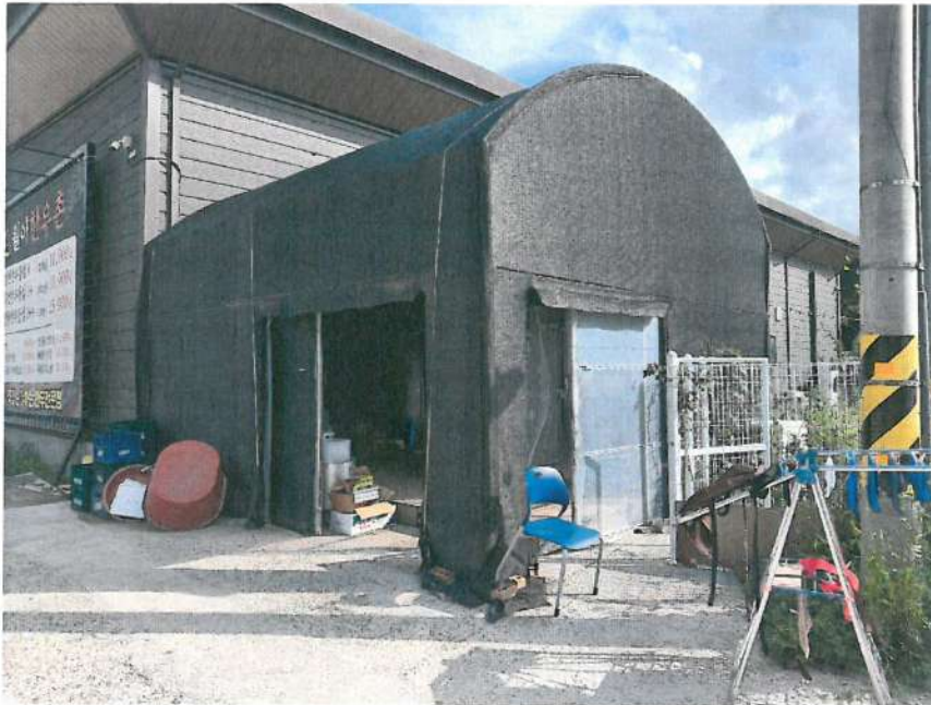
제시외 건물 ㄴ) 전경
