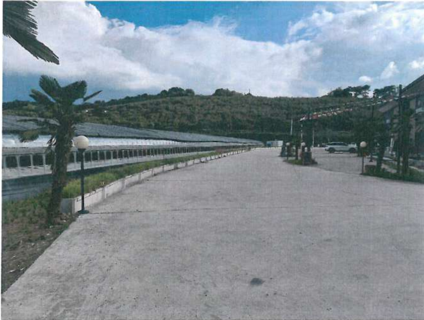
기호 2) 도로 전경
