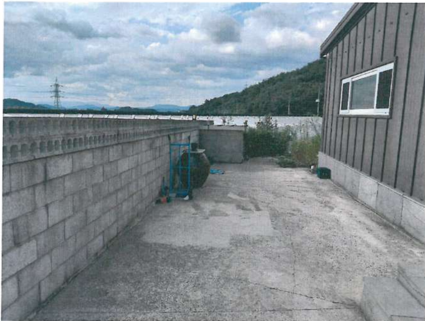
제시외 건물 ㄴ) 전경
