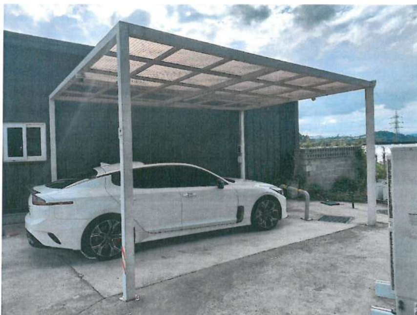
제시외 건물 ㄴ) 전경
