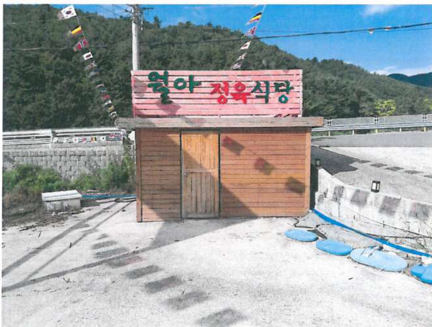
제시외 건물 ㄱ) 전경
