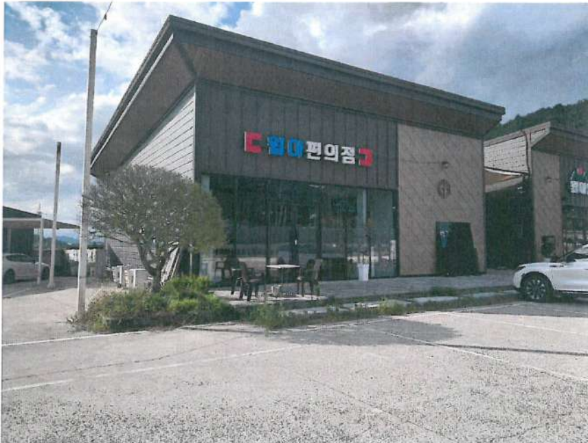
기호 5) 건물 전경
