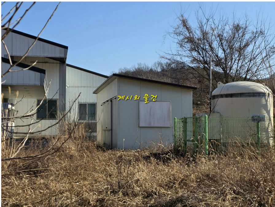
제시외 물건 (기호b) 오폐수처리설비, 경량철골구조 판넬지붕 및 처리구조물 Cap`3 ton, 발생량1.3t 규모, 부대시설 일체
