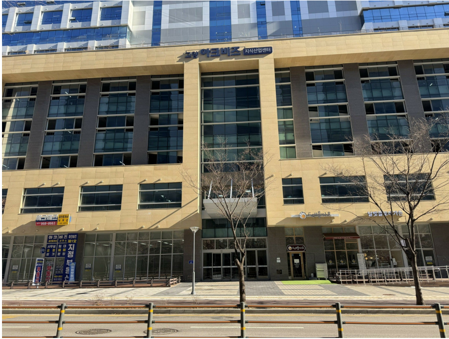
본건 건물 1층 출입구
