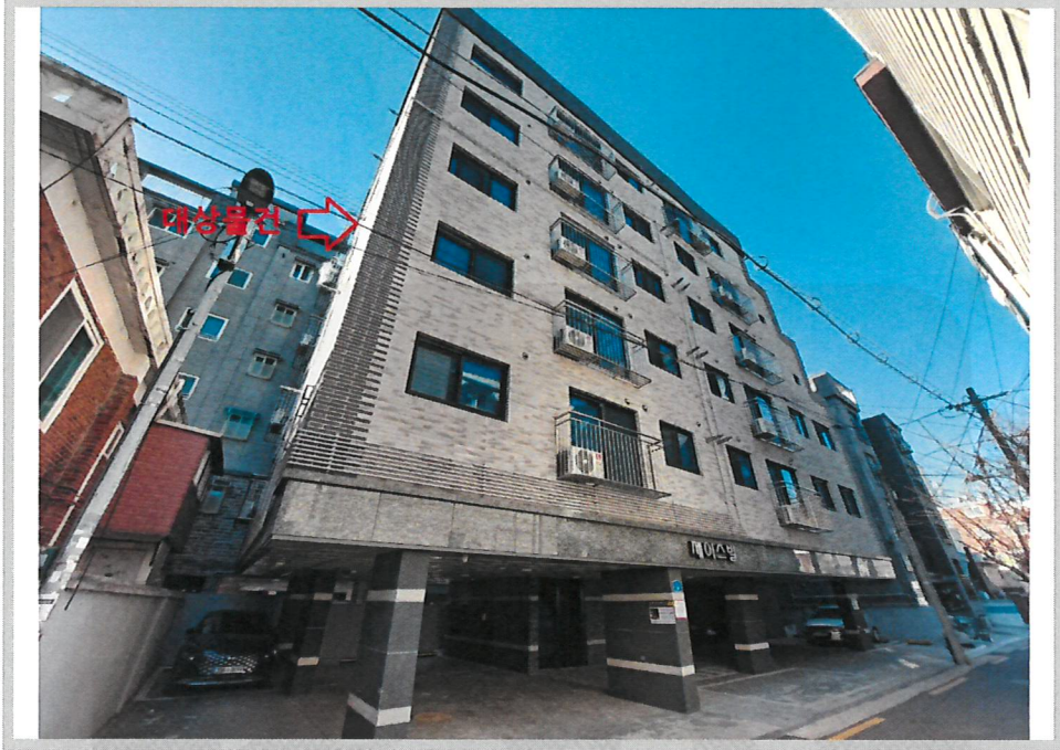
본건 건물 및 대상물건 전경
