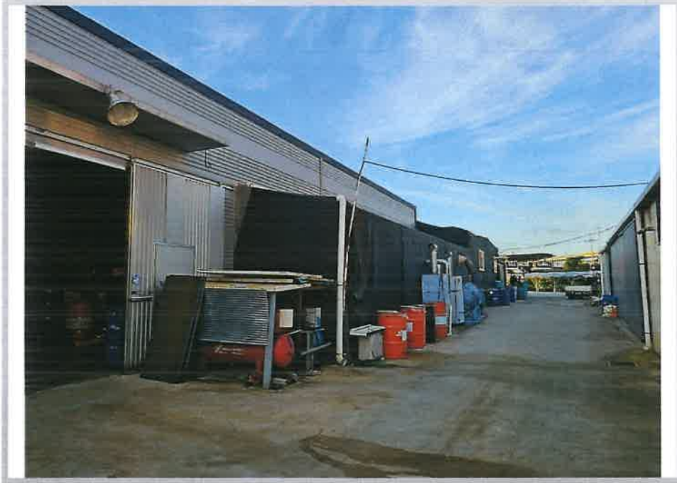
본건 건물 기호 2) 및 제시외건물 기호 ㄷ)
