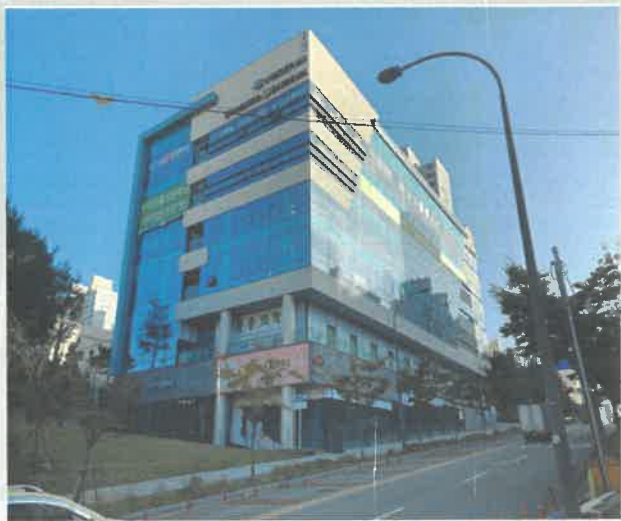
본건 건물 전경
