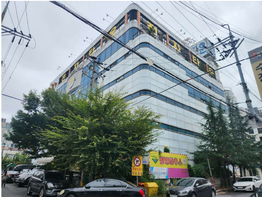
대상물건 소재 건물 전경(북측에서 촬영)
