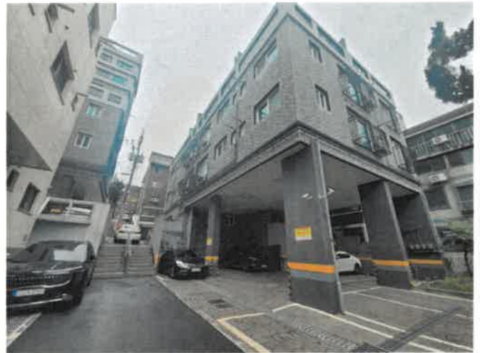
본건 건물 소재 측면
