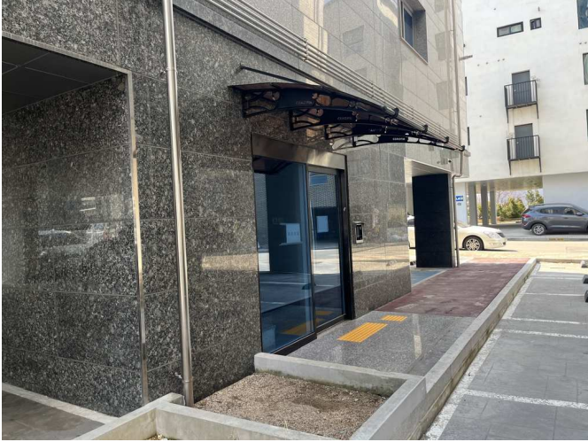
본건 소재 건물 출입문
