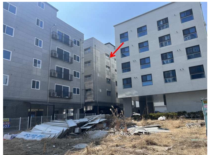
본건 소재 건물 전경 3 (북측방면)
