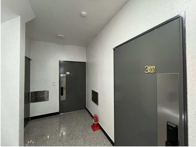
본건 전경 (3층)
