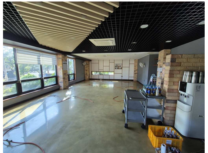
일련번호(2) 1층 내부현황
