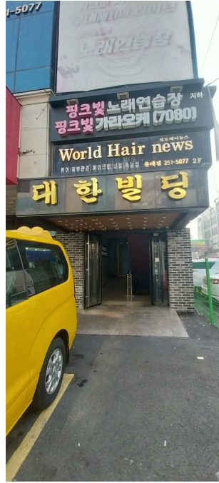
기호3(다) 1층 계단실 출입구
