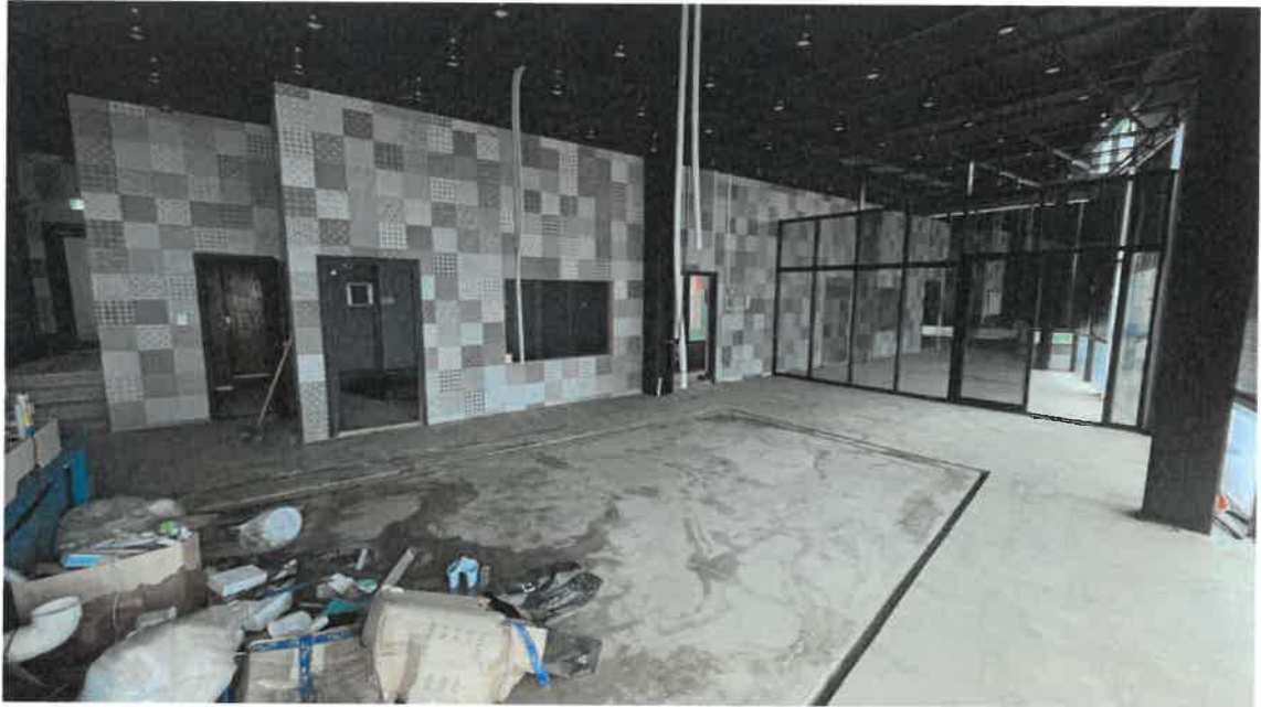
1층 101호 내부전경
