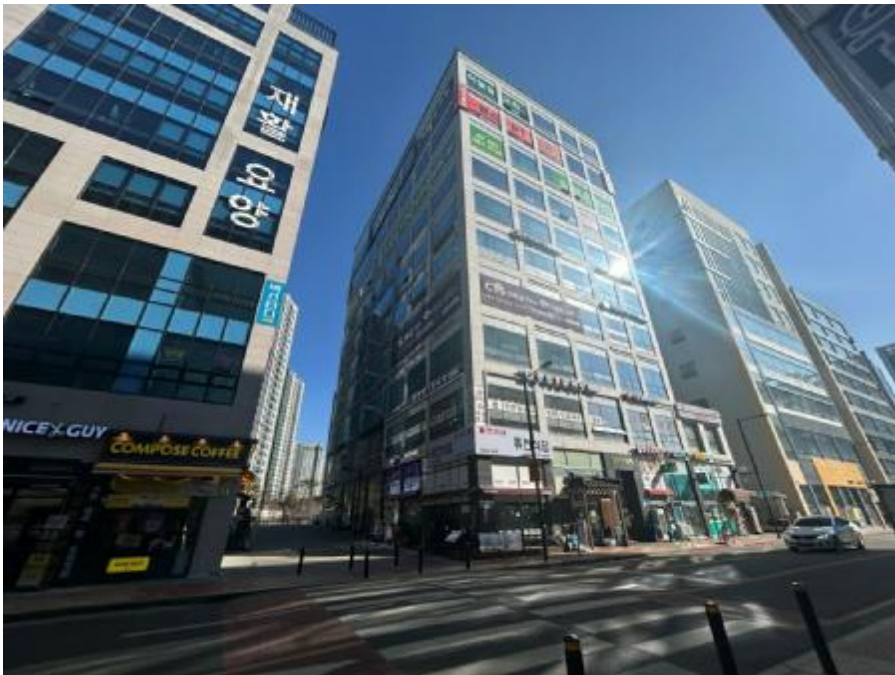
대상물건 건물 남서측 전경
