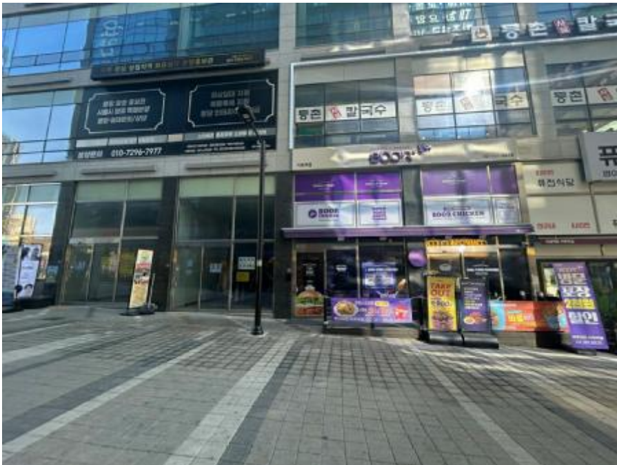
대상물건 1-가 전경
