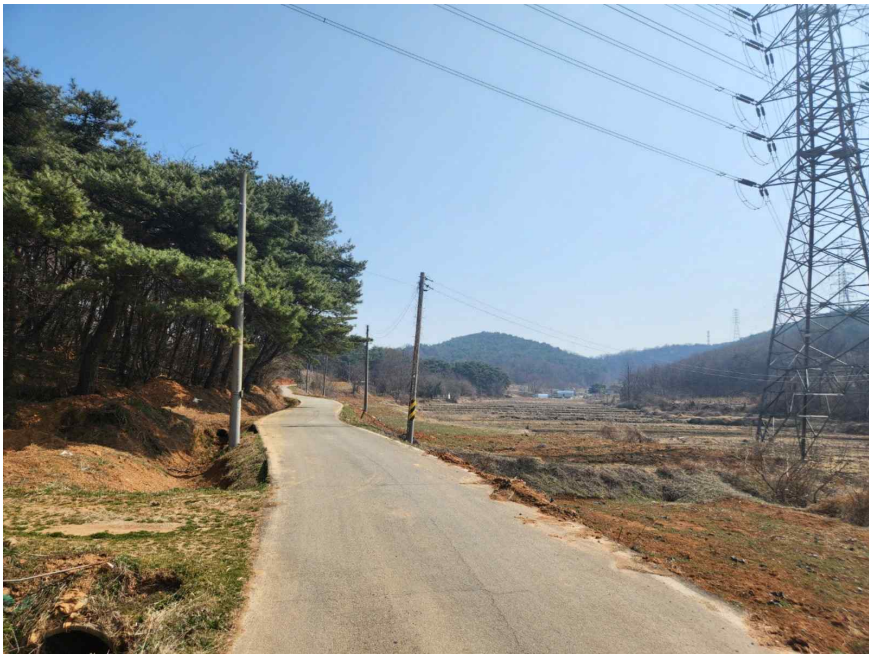
주변환경 - 북동측에서 촬영
