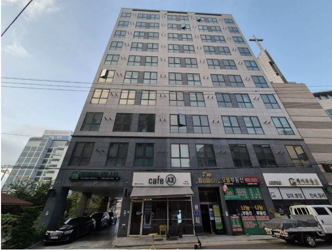
북측에서 촬영한 본건 소재 건물 전면 전경
