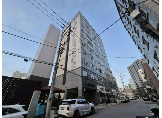
북동측에서 촬영한 본건 소재 건물 전경
