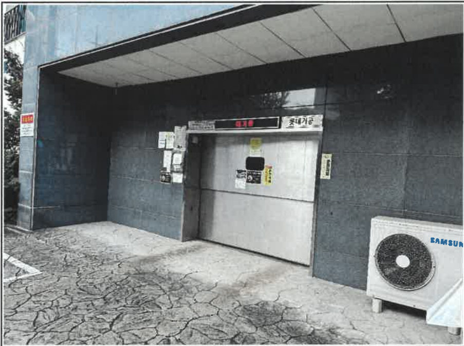
대상물건 건물 소재 기계식주차설비
