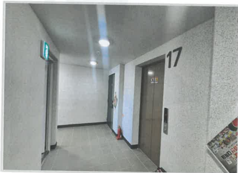
본건 복도 전경
