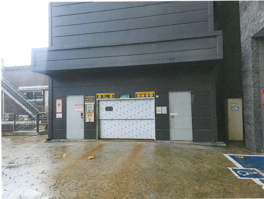
본건 기계식주차장 출입구 전경
