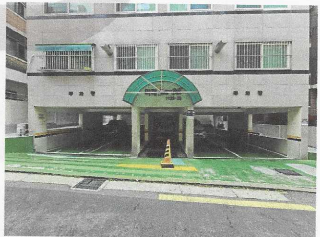
1층 현관 및 주차장
