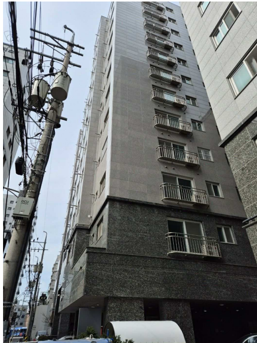
본건(월타운비 3호라인) 전경
